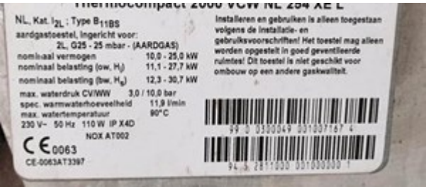
Afb. 9.45 Nominaal vermogen gasketels, 25 kW
