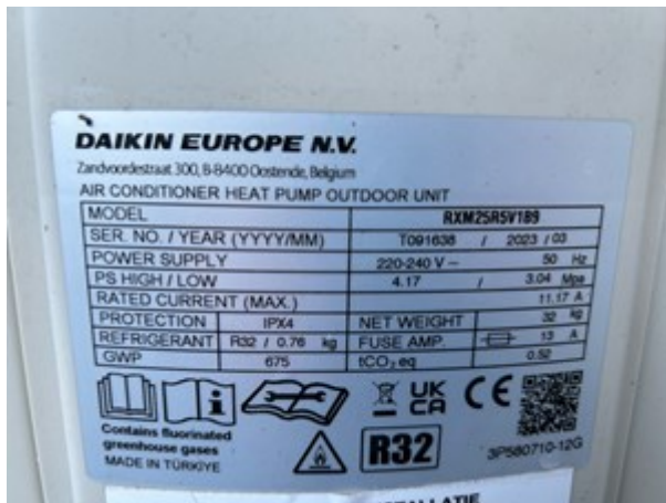
Afb. 10.3 Typeplaatje warmtepomp
