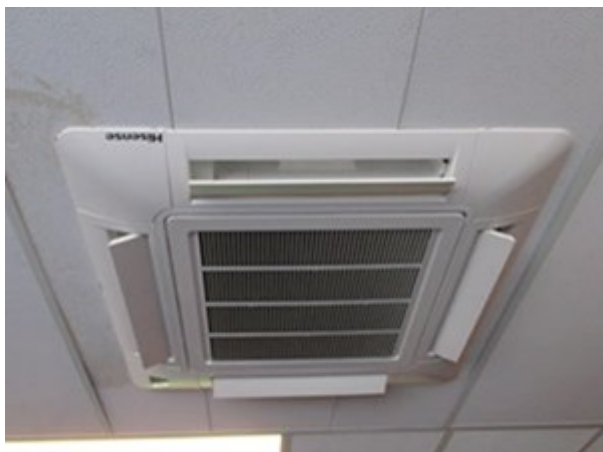
Afb. 10.28 Binnenunit van een splitsysteem (inbouw in plafond)
