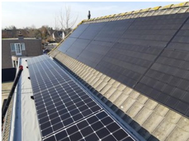
Afb. 15.5 Monokristallijne panelen (zowel de rij links op de foto als rechts op de foto zijn monokristallijne panelen) (bron: Zonnepanelen Xtra BV)
