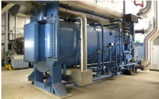
Afb. 10.21 Absorptiekoelmachine
