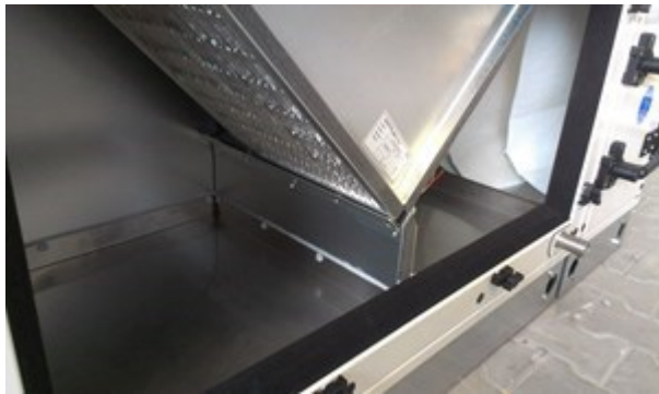
Afb. 11.42 Kruisstroomwisselaar in luchtbehandelingskast
