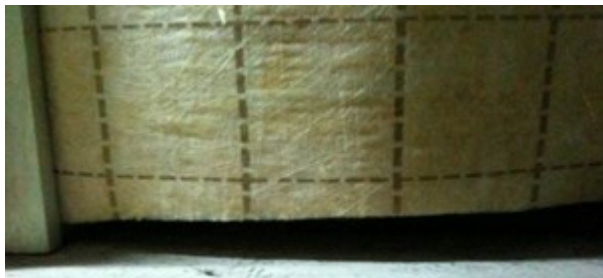
Afb. 8.41 Isolatiemateriaal sluit niet goed aan op de vloer (bron: Nieman)
