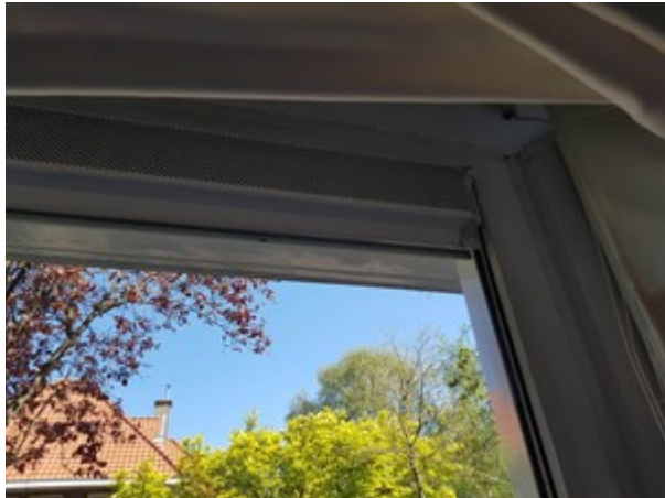
Afb. 8.15 Voorbeeld van een ventilatierooster boven raam
