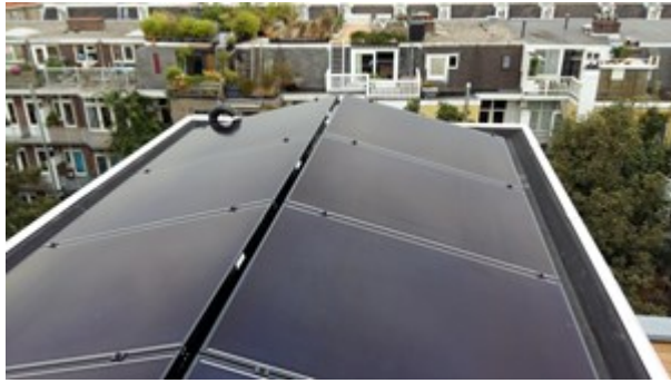
Afb. 15.7 Amorfe panelen (bron: Zonnepanelen Xtra BV)
