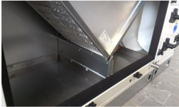
Afb. 11.44 Twin-coil systeem in een luchtbehandelingskast
