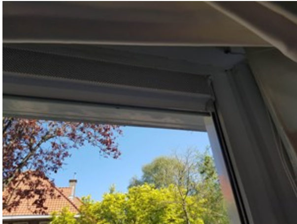
Afb. 11.4 Ventilatie-rooster boven raam
