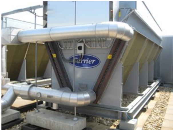
Afb. 10.13 Luchtgekoelde condensor (drycooler) (bron: Carrier)
